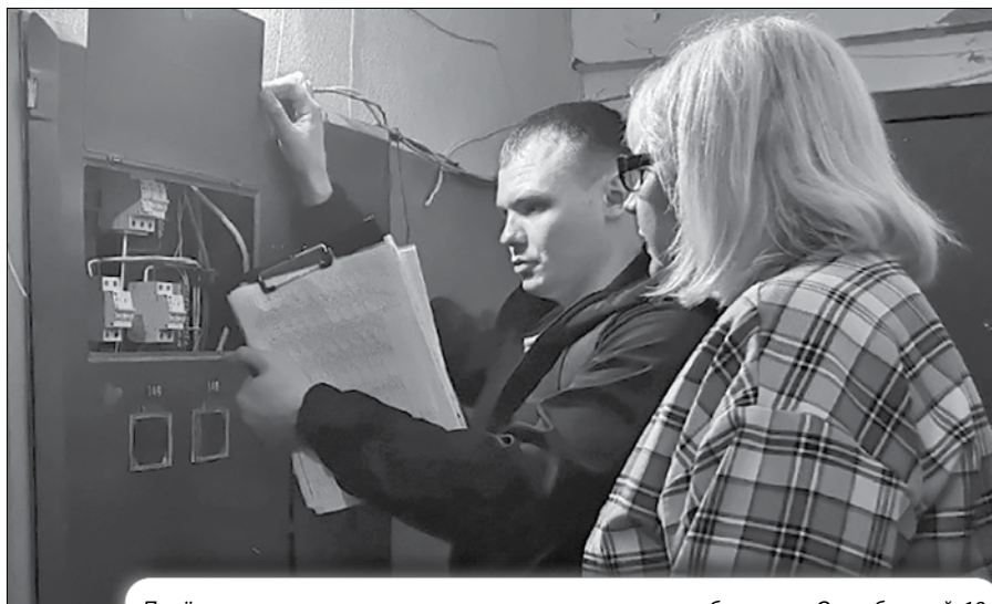
Приёмка капитального ремонта системы электроснабжения на Октябрьской, 18.
