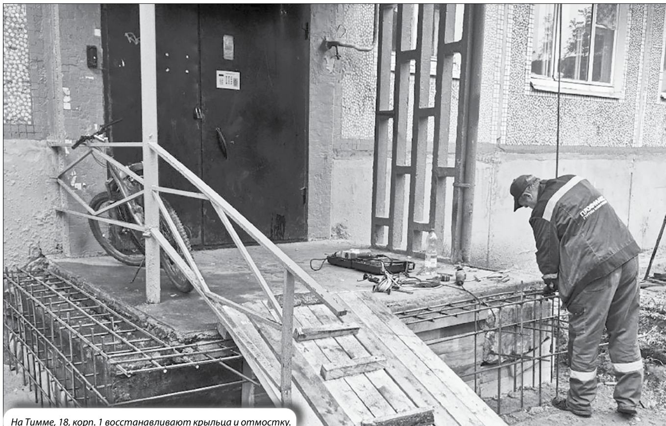
На Тимме, 18, корп. 1 восстанавливают крыльца и отмостку.
