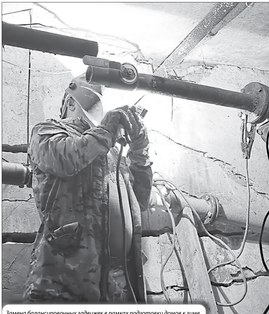
Замена балансировочных задвижек в рамках подготовки домов к зиме.
