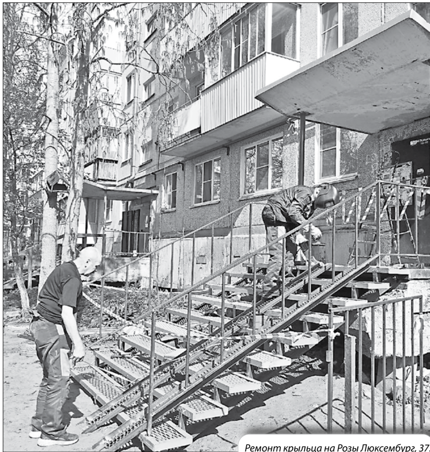
Ремонт крыльца на Розы Люксембург, 37 .
