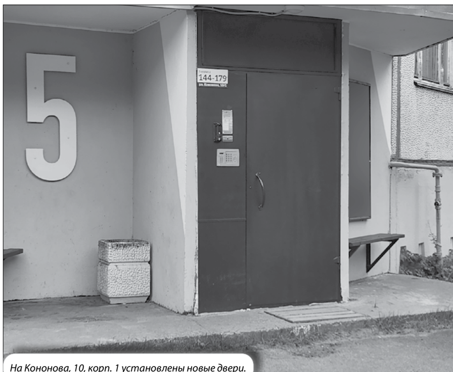
На Кононова, 10, корп. 1 установлены новые двери.
