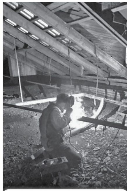
На чердаке на Обводном канале, 32 заменили участок розлива отопления
