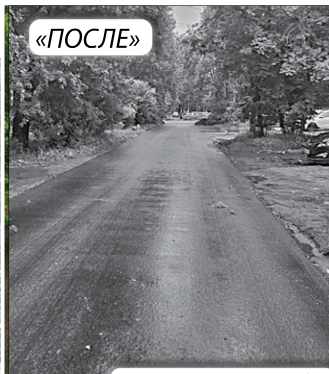
На Воронина, 41 выполнен ремонт проезда
