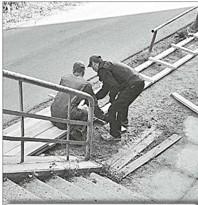
На Ломоносова, 9, корп. 2 оборудовали тротуары.
