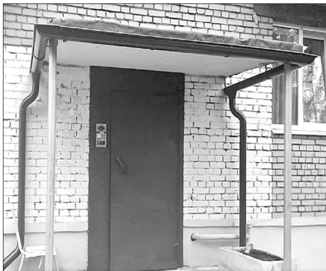
Новый ливнесток подъездного козырька на Комсомольской, 14
