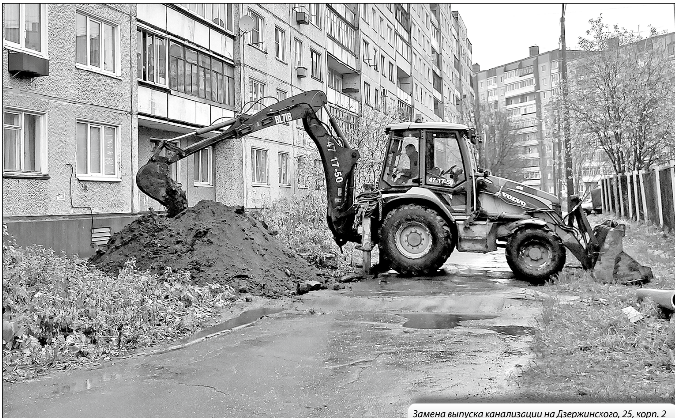
Замена выпуска канализации на Дзержинского, 25, корп. 2
