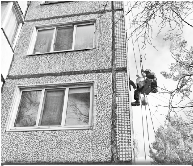
Герметизация межпанельных швов на Воронина, 31, корп. 3
