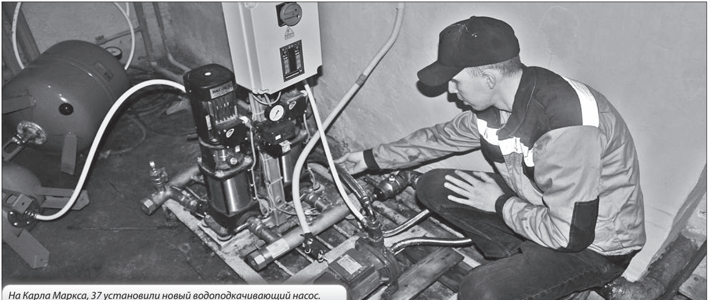
На Карла Маркса, 37 установили новый водоподкачивающий насос.
