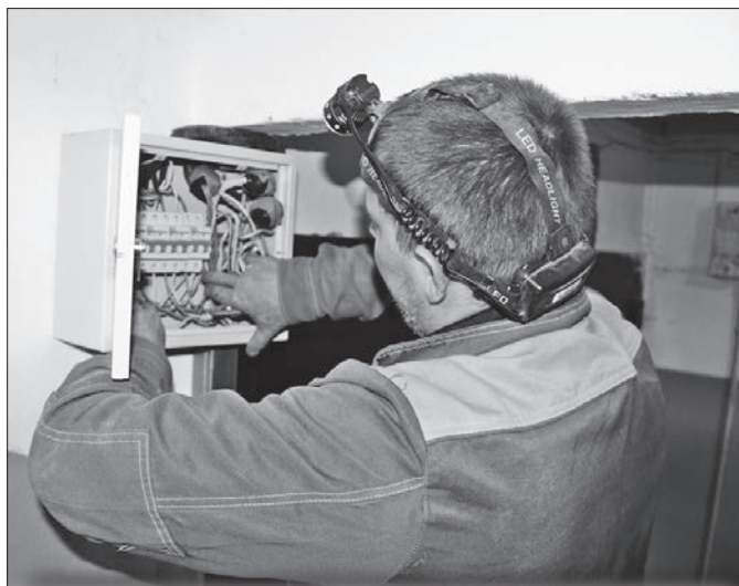
На Ленинградском, 271 капитально отремонтировали систему электроснабжения.
