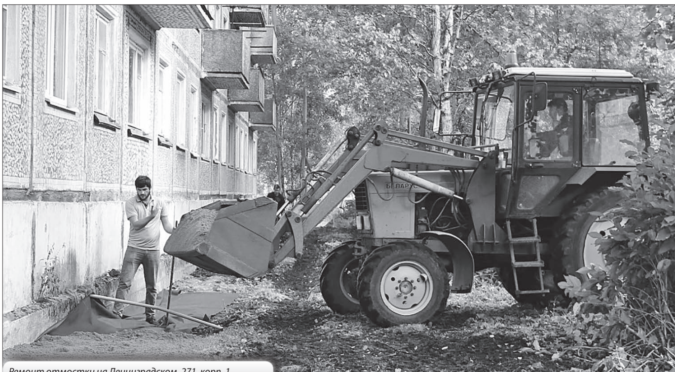
Ремонт отмостки на Ленинградском, 271, корп. 1.
