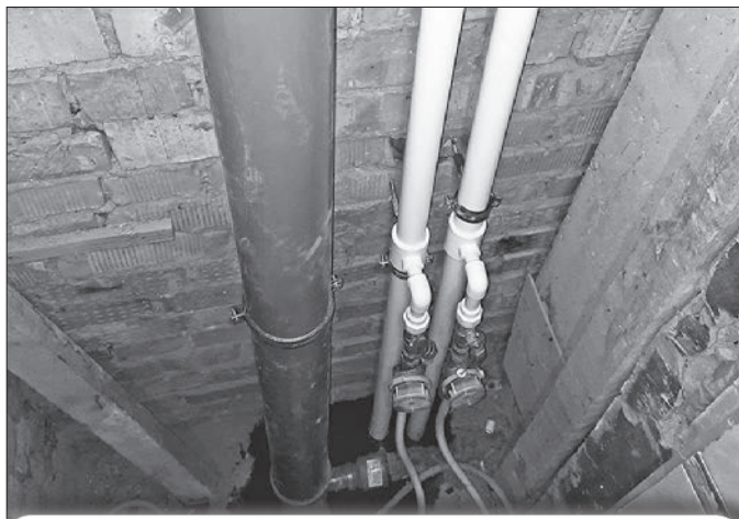
На Советской, 32 заменили стояки водоснабжения и канализации.
