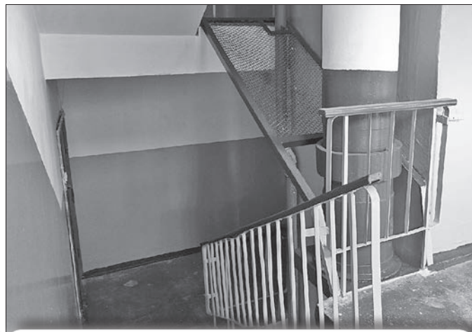
На Беломорской Флотилии, 4 завершили косметический ремонт в 4-м подъезде.
