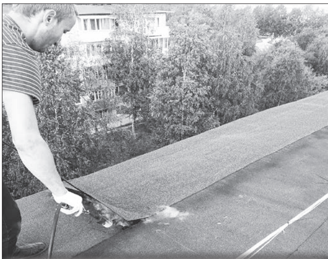
На Адмирала Кузнецова, 27 в местах протечек выполнен текущий ремонт кровли.
