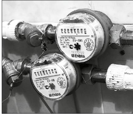
Давление в стояках холодной и горячей воды всегда немного отличается. Если соединить стояки, вода из трубы с большим давлением начнёт перетекать в трубу с меньшим. Это и есть подмес. Такой переток весьма дорого обходится жильцу, виновному в подмесе: у него начинают крутиться оба счётчика и «накручивать» несуществующий расход воды.
