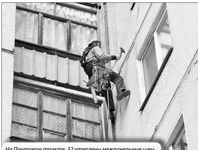
На Почтовом тракте, 32 утеплены межпанельные швы.
