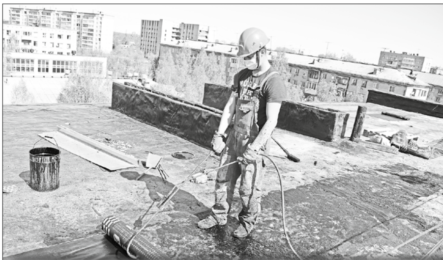
На Ленинградском, 341, корп. 1 капремонт кровли провели с помощью механизма рассрочки платежа.
