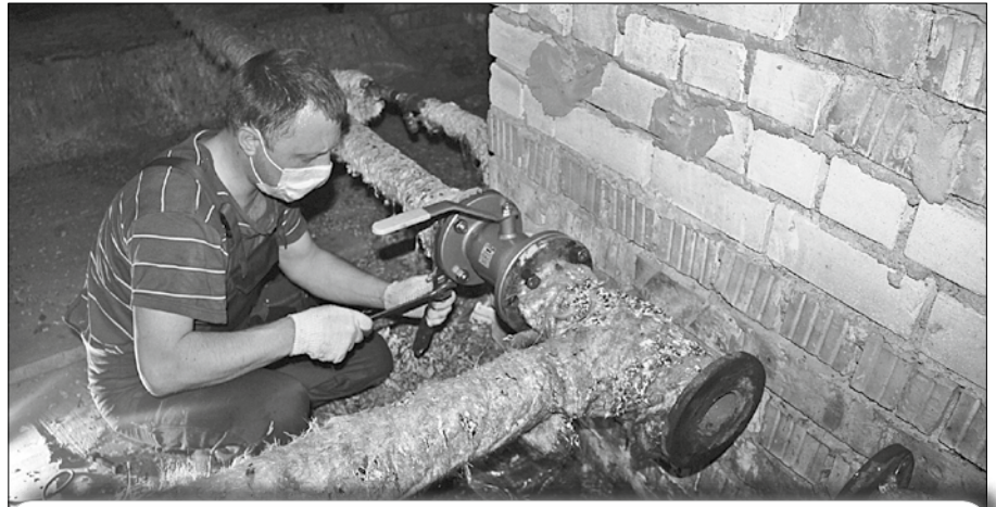
Монтажник санитарно-технических систем и оборудования ООО «УК Садовый Район» А. А. Горбунов меняет задвижки на системе отопления на Выучейского, 28.
