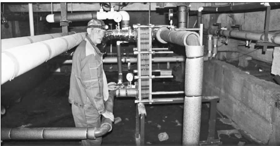
Монтажник санитарно-технических систем и оборудования ООО «Результат» С. А. Новосёлов в тепловом пункте на Ленинградском, 271, корп. 1.
