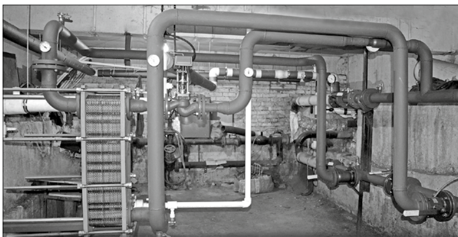
На Кедрова, 38 (ООО «РСК «Метелица+») в ходе подготовки к отопительному сезону установили новый пластинчатый теплообменник.
