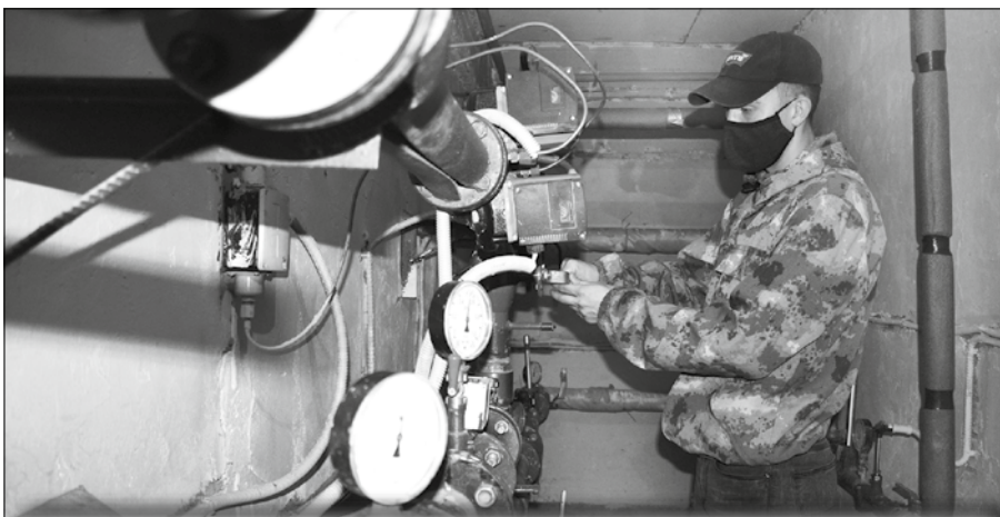
Начальник участка ООО «УК «Жилой Квартал» В. В. Киселёв проводит ревизию теплового пункта на К. Маркса, 37.
