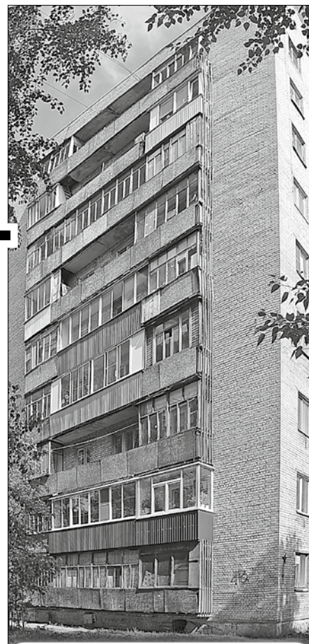
Жителям Ленинградского, 283, корп.1 необходимо восстановить пути эвакуации на лоджиях дома.
