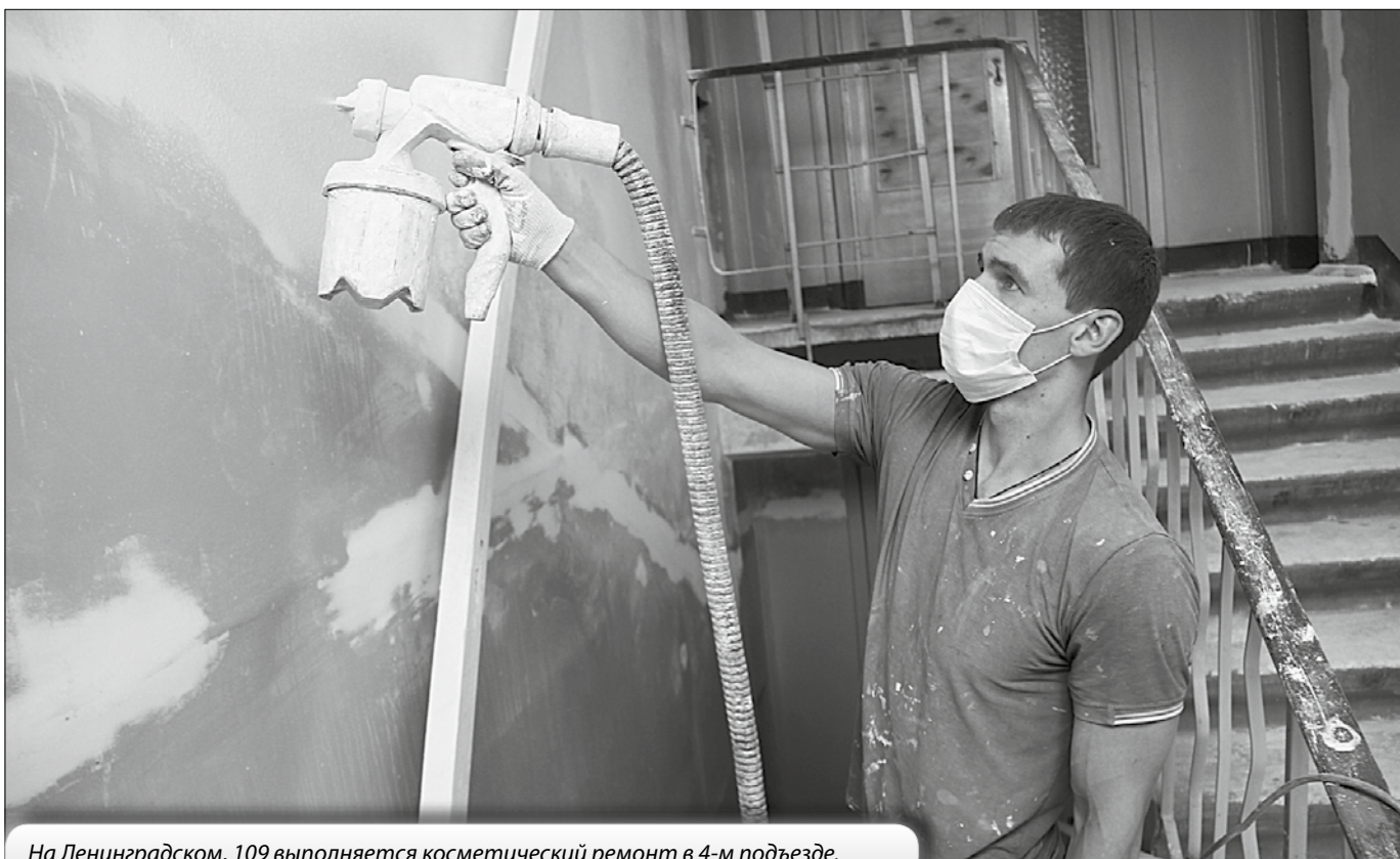
На Ленинградском, 109 выполняется косметический ремонт в 4-м подъезде.
