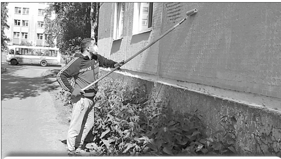
На Троицком, 184 красят фасад дома в районе первого этажа.
