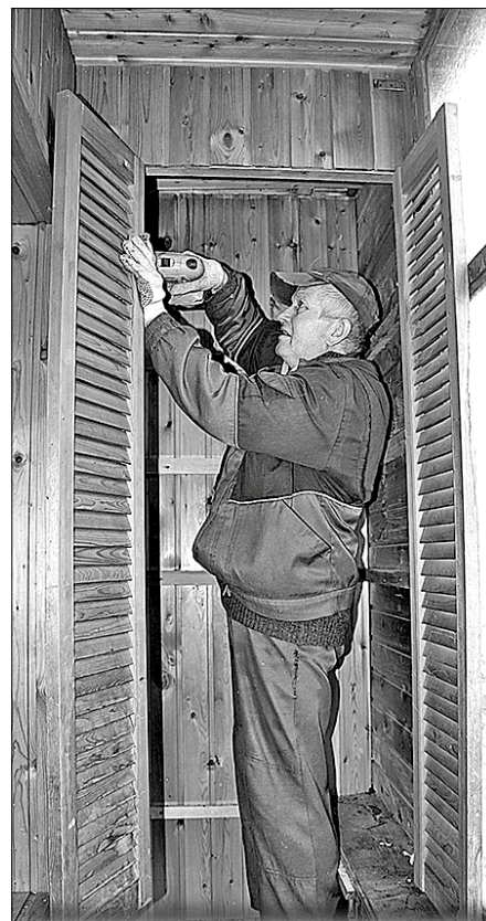
Работники УК «Фактория-1» в мае 2019 года разобрали перегородки между балконами в нескольких квартирах. Остальные собственники до сих пор отказываются исполнять предписания пожарного надзора.
