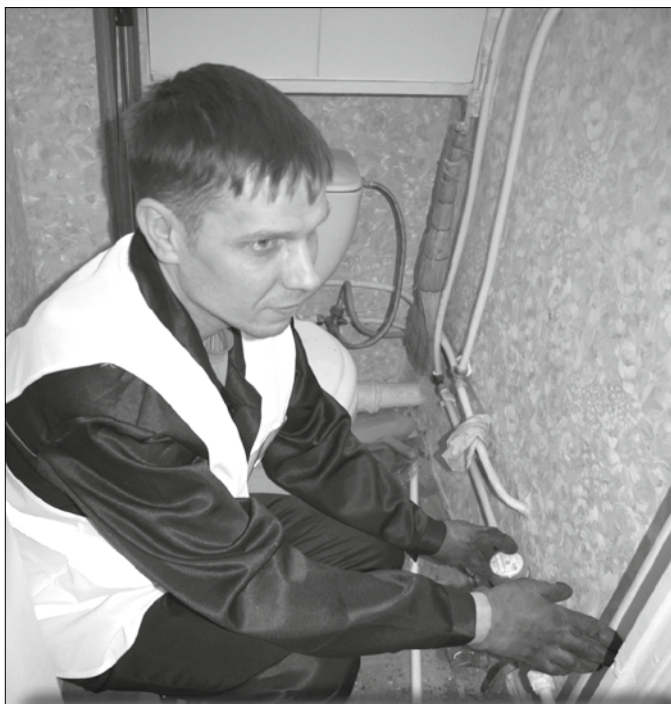
Монтажник санитарно-технических систем и оборудования ООО «Аварийно-ремонтное предприятие» В. С. Иванов ремонтирует квартирные стояки водоснабжения на Маяковского, 27
