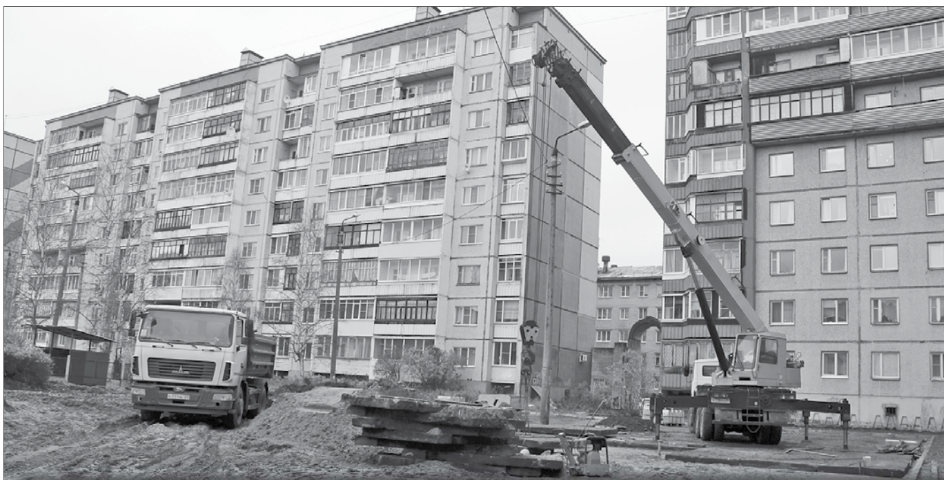
Ремонт двора на Розы Люксембург, 23 в разгаре. Здесь поднимут участок перед входами в подъезды и восстановят дренажно-ливневую канализацию.
