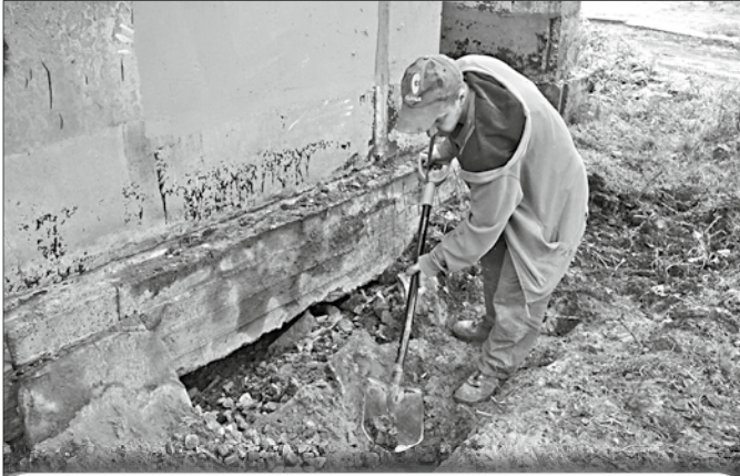
Р. Р. Адаев восстанавливает отмостку по периметру дома на Новгородском, 32, корп. 1.
