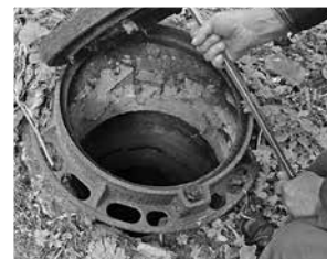
Слесарь ООО «УК «Содействие» С. А. Шарипов проверяет состояние наружных канализационных колодцев около дома на Никитова, 18.
