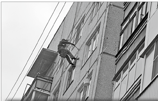
На Новгородском, 41 производится утепление межпанельных швов.
