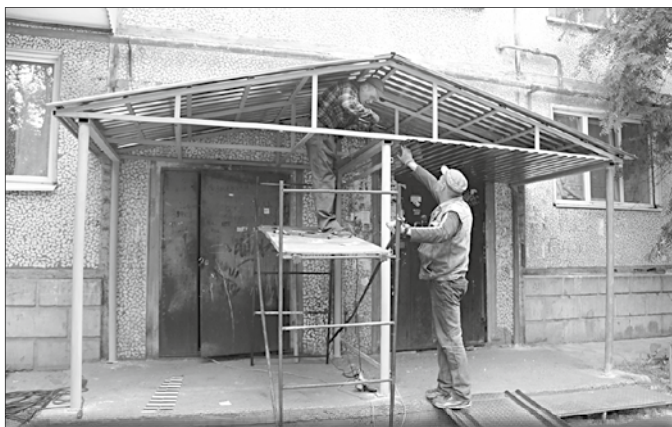
М.С. Крылов и А.С. Чушков монтируют козырёк над 5-м подъездом на Воронина, 39.
