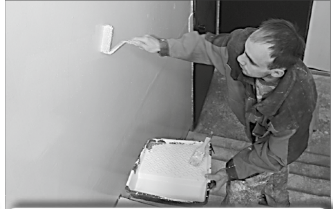
В. Э. Диев выполняет косметический ремонт в 5-м подъезде на Адмирала Кузнецова, 16, корп. 2.
