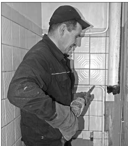
Электрогазосварщик «Аварийно-ремонтного предприятия» А. А. Артамонов меняет стояки в квартире.
