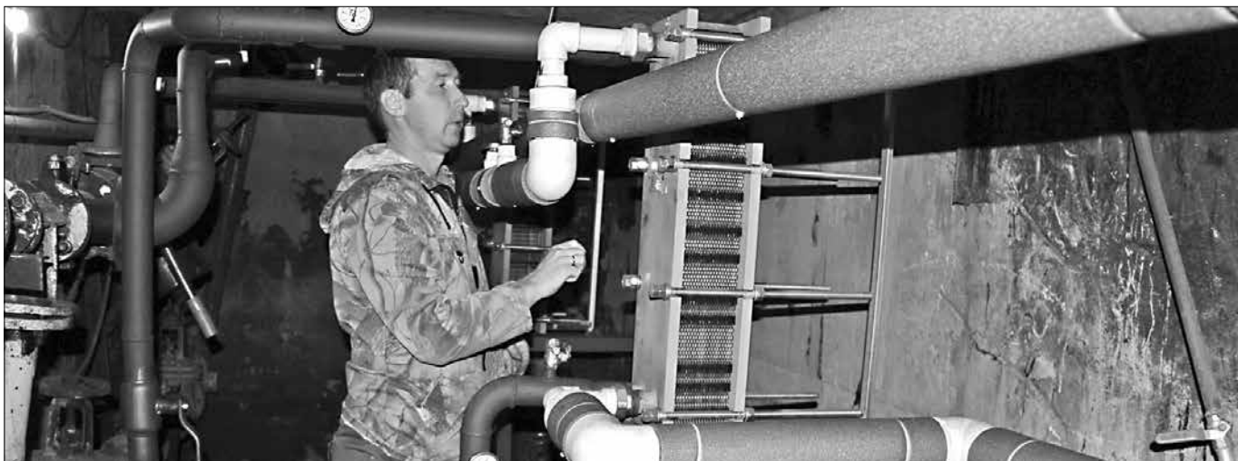
На Советской, 35 этим летом заменили устаревшие скоростные водоподогреватели на современные и эффективные пластинчатые теплообменники. И.В. Панов, представитель подрядной организации ООО «Архэнергоаудит», проверяет качество работ.
