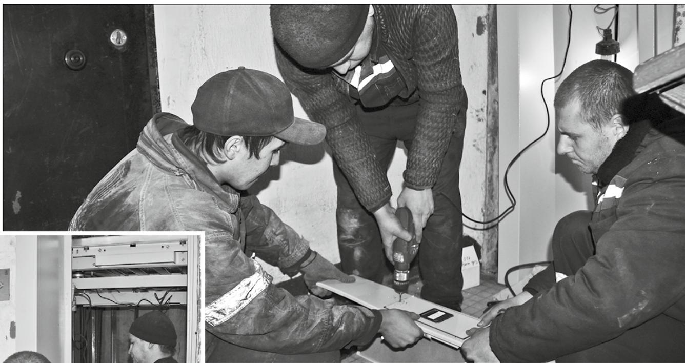
*Бригада монтажников лифтового оборудования подрядчика ПАО «Карачаровский механический завод» А. З. Нагимов, Д. А. Иванов, Р. В. Бекетов устанавливает табло лифта в доме по адресу пр. Ломоносова, 90.*
