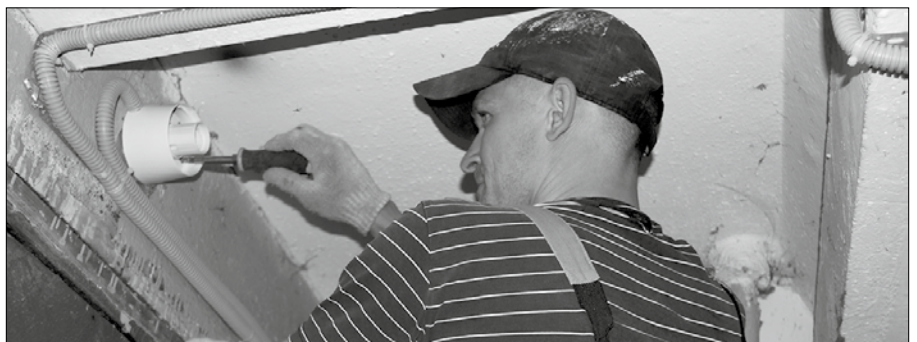
На Воронина, 33 в подъездах монтируют светодиодные светильники с датчиками движения и звука.
