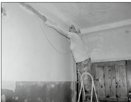
На Бадигина, 24 косметический ремонт проведут во всех подъездах.
