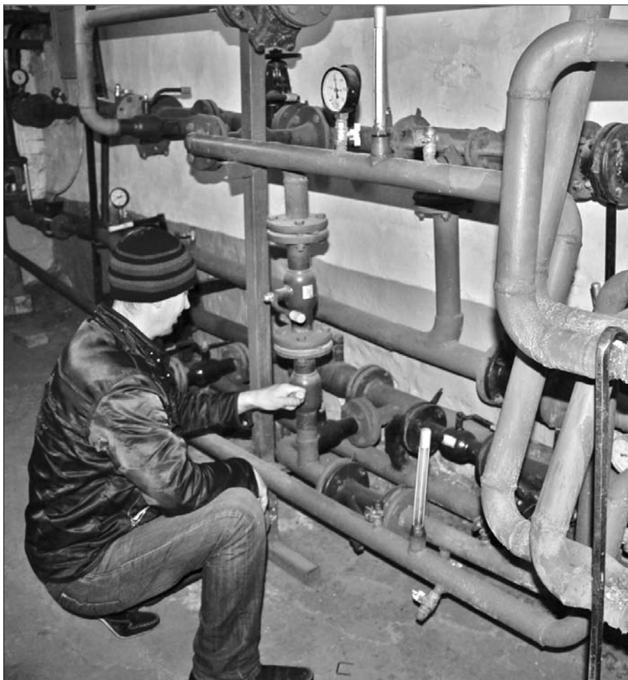
Монтажник СТС проверяет тепловой пункт на Комсомольской, 9, корп. 2 перед запуском отопления.
