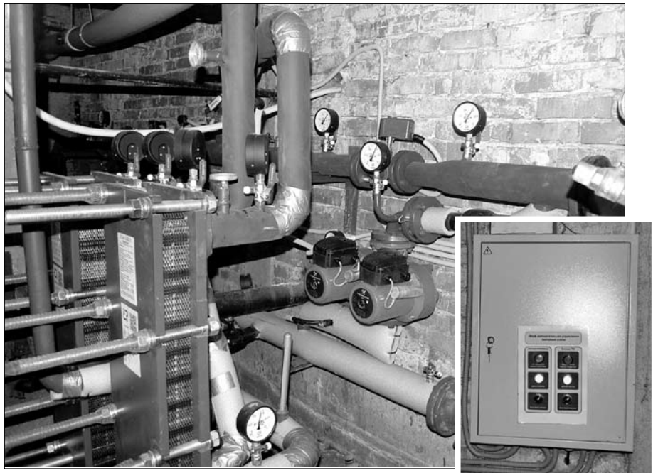
На Гайдара, 27 автоматический тепловой пункт смонтировали в 2015 году
