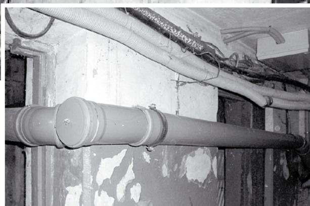
В доме наполовину заменили систему канализации.
