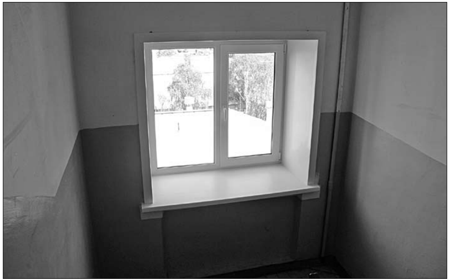
На Комсомольской, 9, корп. 2 в рамках капитального ремонта установили пластиковые окна на лестничных клетках.
