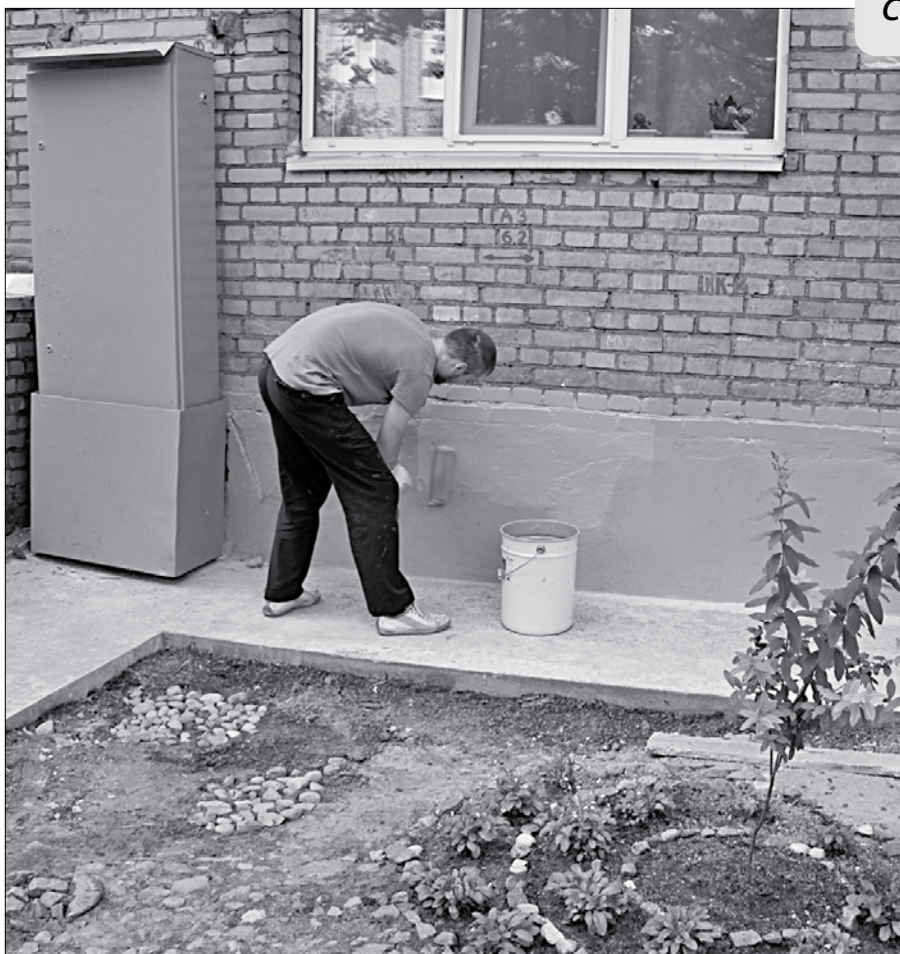
Работники подрядной организации завершают капитальный ремонт на Комсомольской, 9, корп. 2. В доме починили отмотску и цоколь.
