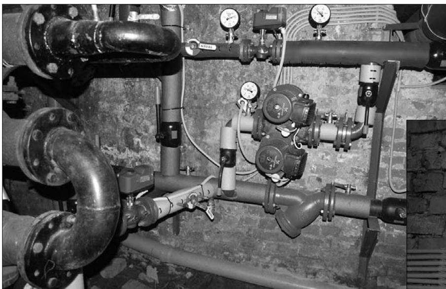
На Гагарина, 1 в 2013 году установили автоматический тепловой узел. Датчики реагируют на температуру воздуха, подача теплоносителя снижается или повышается в зависимости от погодных условий.
