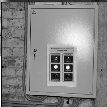
На Гайдара, 27 установили автоматический тепловой узел (АТУ), который позволяет оптимизировать процесс отопления многоэтажки. Датчики температуры подстраивают батареи под погодные условия, как результат – никаких перетопов.
