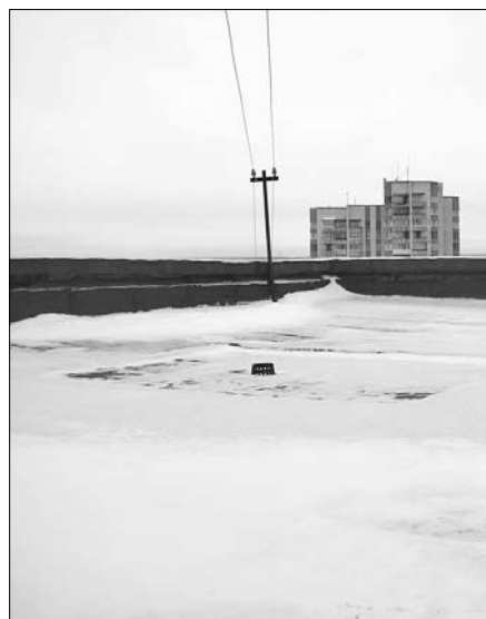
На Суворова, 11, корп. 1 капитально отремонтировали кровлю.
