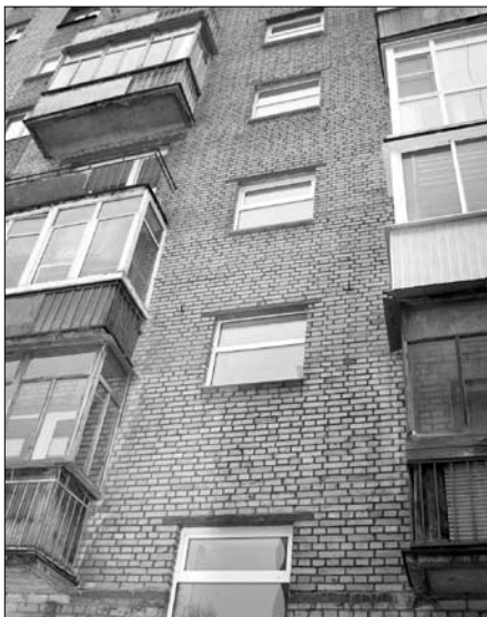
На Комсомольской, 9 установили пластиковые окна на лестничных клетках.
