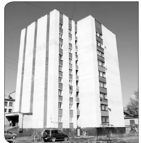
На Никольском, 148 будет отремонтирована кровля. Собственники пришли к общему решению, и уже определен подрядчик.
