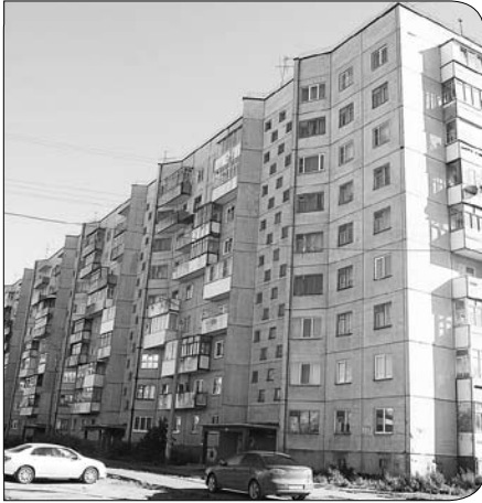
На Бадигина, 24 (ООО «ГУК») завершаются работы по ремонту канализации, а также замене розлива холодного водоснабжения.
