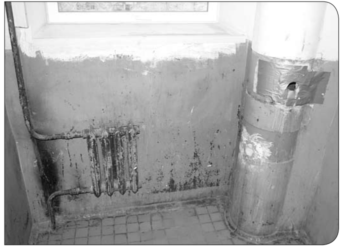
На Тимме, 9, к. 2 в разгаре косметический ремонт подвездов.
