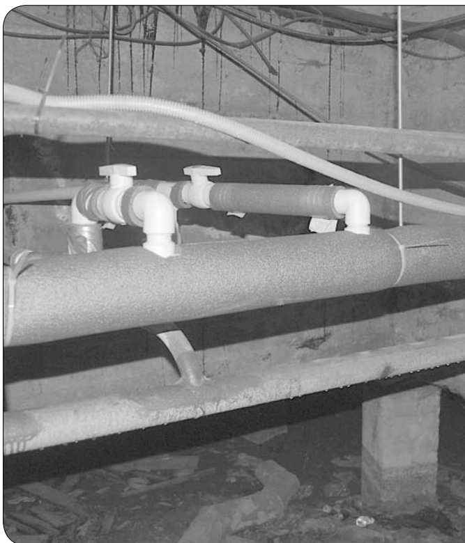
Недавно в доме завершили ремонт розлива горячего водоснабжения и канализации. Старые трубы заменили на новые, более широкого диаметра.
