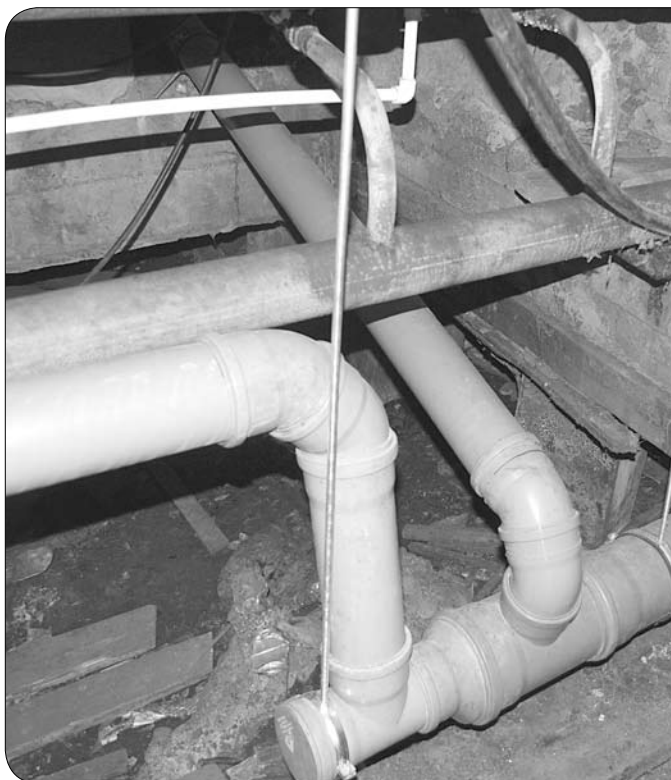
Недавно в доме завершили ремонт розлива горячего водоснабжения и канализации. Старые трубы заменили на новые, более широкого диаметра.
