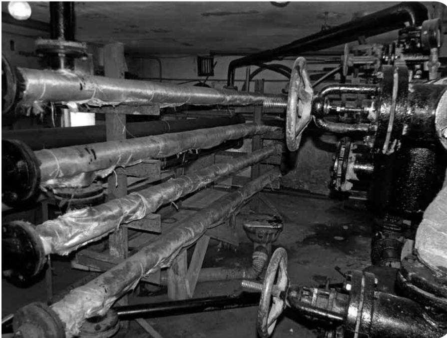
Практически все тепловые пункты в домах, обслуживаемых УК «Соломбала», находятся в удовлетворительном техническом состоянии.
