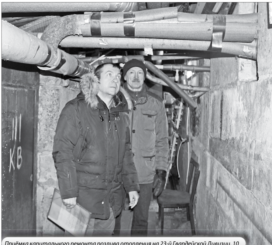
Приёмка капитального ремонта розлива отопления на 23-й Гвардейской Дивизии, 10
