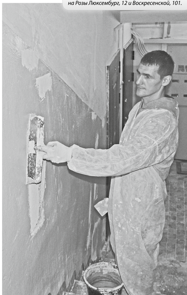
Косметический ремонт в подъездах идёт на Розы Люксембург, 12 и Воскресенской, 101.
