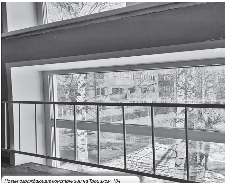
Новые ограждающие конструкции на Троицком, 184
