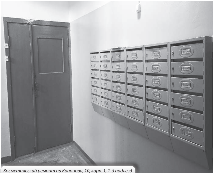
Косметический ремонт на Кононова, 10, корп. 1, 1-й подъезд
